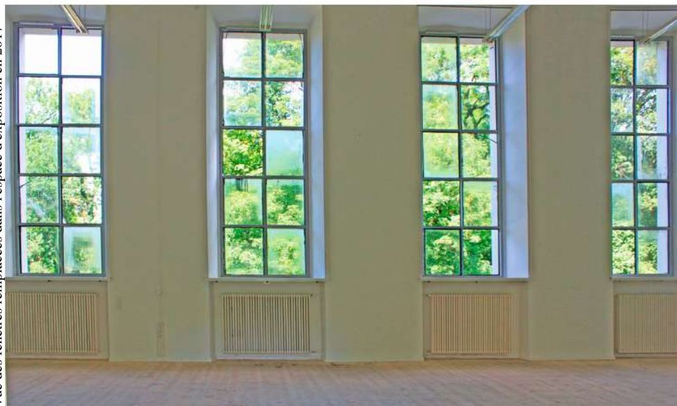
Vue des fenêtres remplacées dans l'espace d'exposition en 2017
